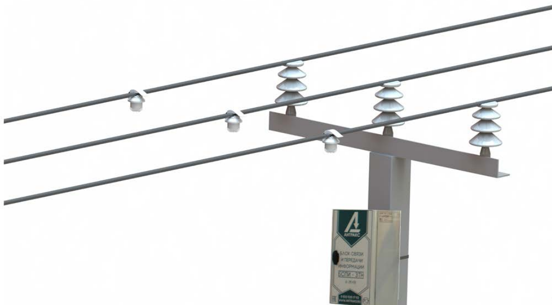
Рисунок 2 – Пример установки индикаторов ИКЗ-В34 из комплекта ИКЗ-В34-ТНЗ
