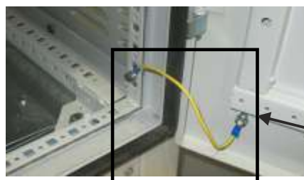
а) заземление элементов корпуса
