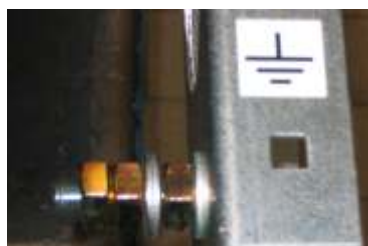
а) болт заземления
