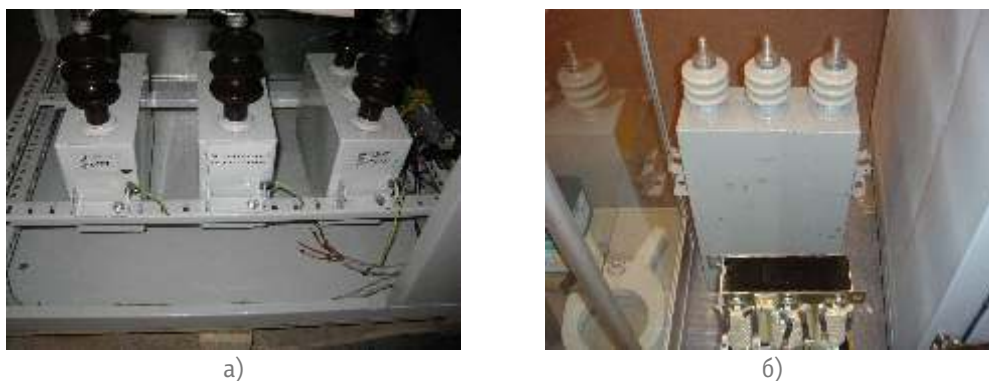
Рис.1 Конденсаторы. а) однофазные, б) трехфазные
