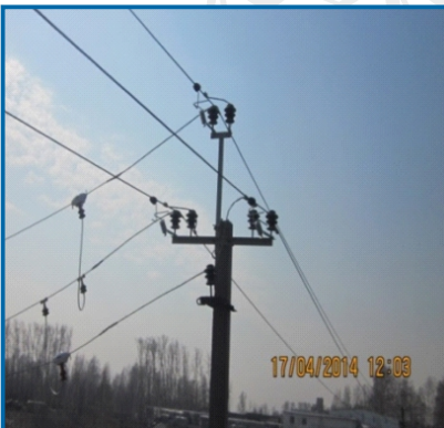
Монтаж на линии
