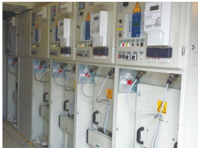
Оперативные шинки из шкафа в шкаф прокладываются через проемы в релейном шкафу. Также, по желанию заказчика, возможна прокладка контрольных кабелей и шинок питания в кабельных лотках по верху релейных шкафов. По исполнению шкафы подразделяются на шкафы с выкатными элементами (с выключателями, с трансформаторами напряжения, с трансформаторами собственных нужд, с разъединителем и др.), а также без выкатных элементов (глухого ввода, кабельных разделок и др.). Шкафы могут иметь следующие исполнения:
