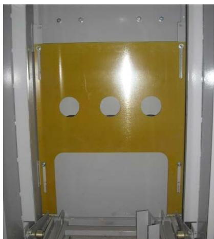
✓ возможность заземления любого участка главных цепей с помощью стационарно установленных заземляющих разъединителей. Конструкцией КРУ КМ-1 предусмотрены два типа заземляющих разъединителей: с механизмом замыкания, скорость срабатывания которого зависит от оператора; с быстродействующим механизмом замыкания, скорость срабатывания которого не зависит от оператора.
